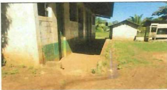
Foto 5: MANTENIMIENTO DE PISO Y MURO
