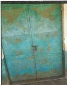
Foto 3: MANTENIMIENTO DE PUERTA
