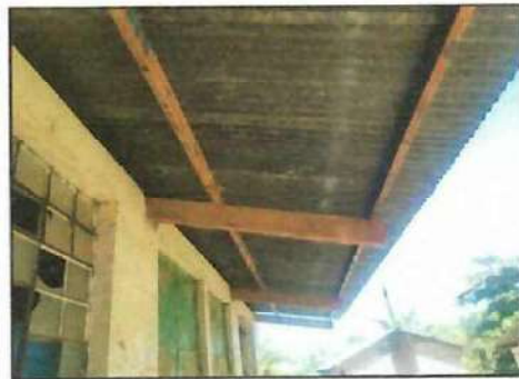
Foto 4: MANTENIMIENTO DE ESTRUCTURAS METÁLICAS
