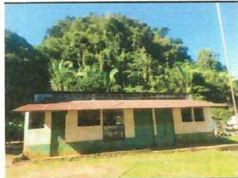
Foto 2: CAMBIO DE TECHOS
