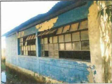
Foto 1: CAMBIOS DE VIDRIOS PARA VENTANAS
